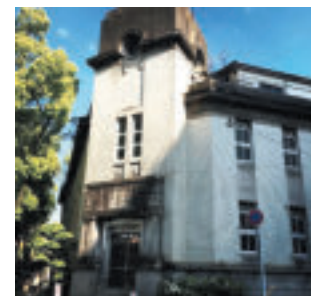
写真③：旧長崎警察署(大正13年竣工)見学
